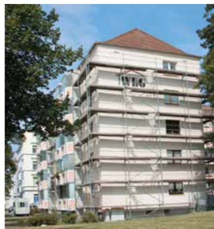
Durch die eingerüstete Fassade noch ein letzter Blick auf das alte Logo
