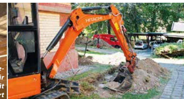
Die Ladeinfrastruktur für die E-Mobilität wird montiert
