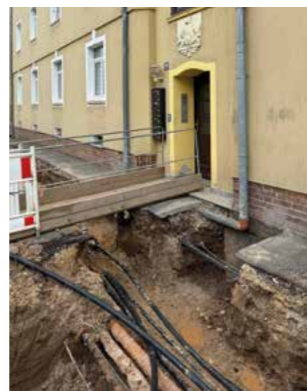
In der Uhlstraße werden die Hausanschlüsse vorbereitet
