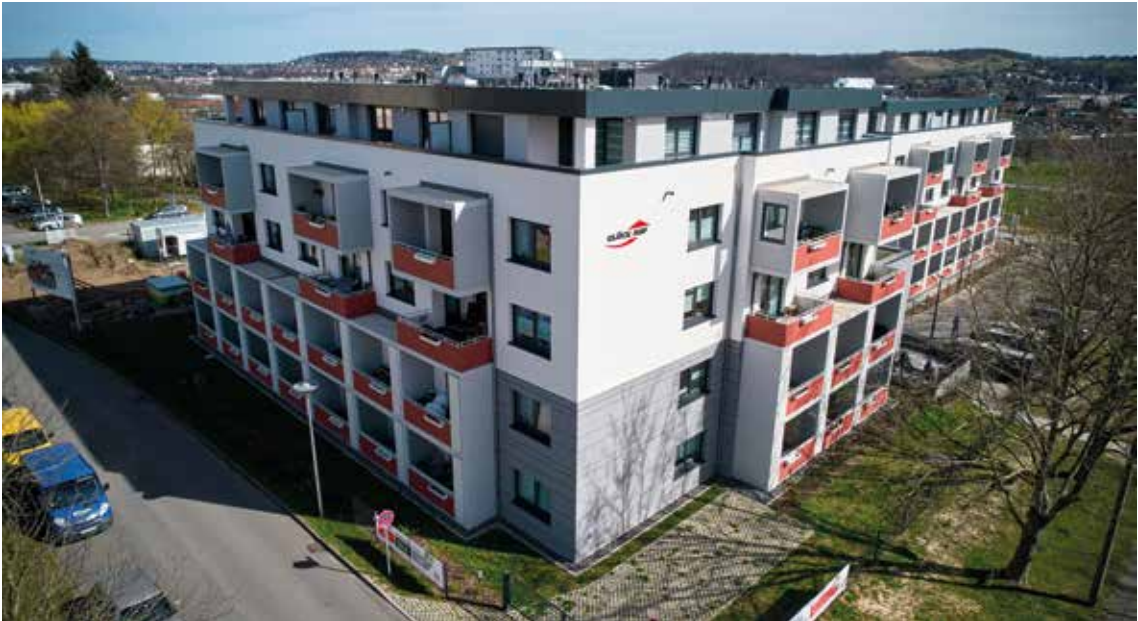
Der erste und zweite Bauabschnitt im WeidenCarré sind fertiggestellt. Am dritten Haus wird mit Hochdruck gearbeitet, damit die Wohnungen im Frühjahr 2026 bezugsfertig sind.
