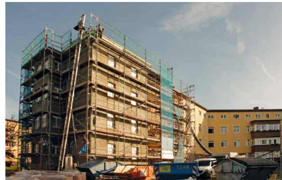
Im Haus Straße des Bergmanns 56/58 hat der Umbau begonnen. Neue Grundrisse sowie größere Bäder und Küchen schaffen künftig modernen Wohnraum. Die Balkone werden erneuert – angelehnt an das historische Vorbild.
