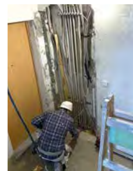
Komplett neu auch die elektrischen Anlagen im Treppenhaus
